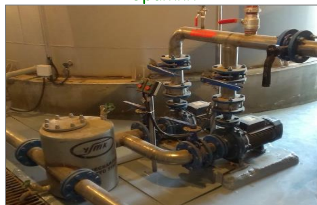
Механическая ловушка и насосы бражки
