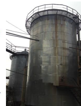
UASB реакторы меласной барды и для стоков с нагрузкой до 20 кг ОВ/м.куб
