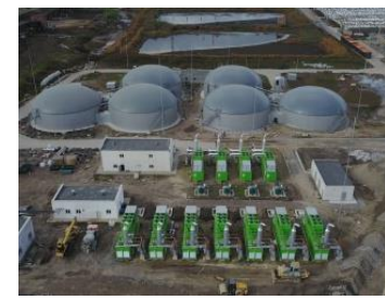
Сельскохозяйственные реакторы с нагрузкой до 5 кг ОВ/м.куб
