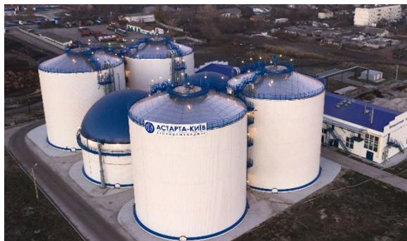
Глобіно на буряковому жомі, силосі та гною, 150 тис. м 3 /добу БГ, Україна
